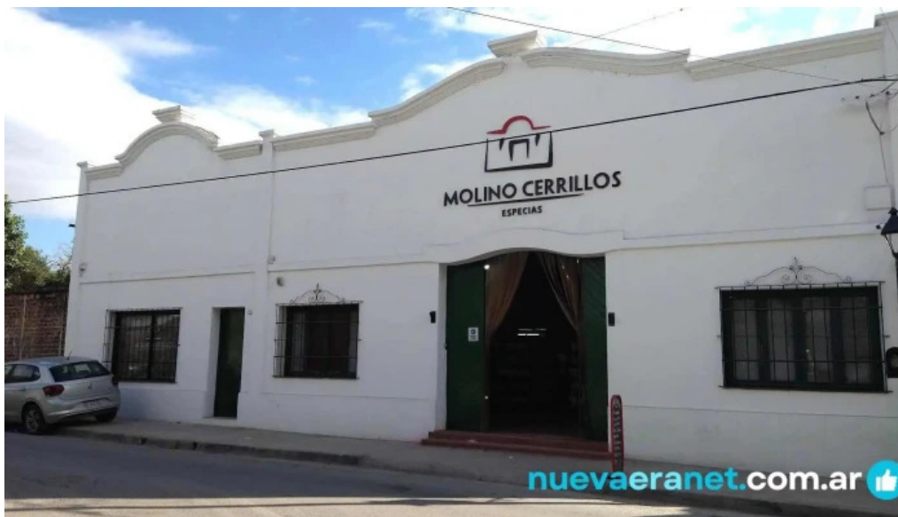
Molino cerrillos cerrillos
