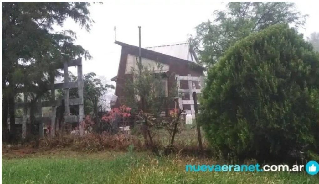
Casa g posada rustica bioconstruccion tiny house exterior
