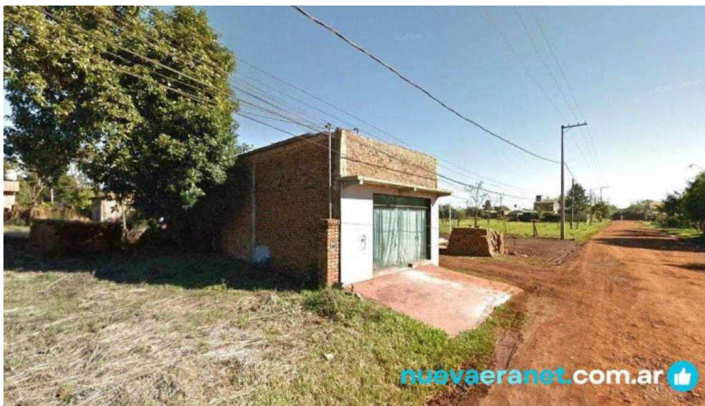
Panaderia tyncho obra
