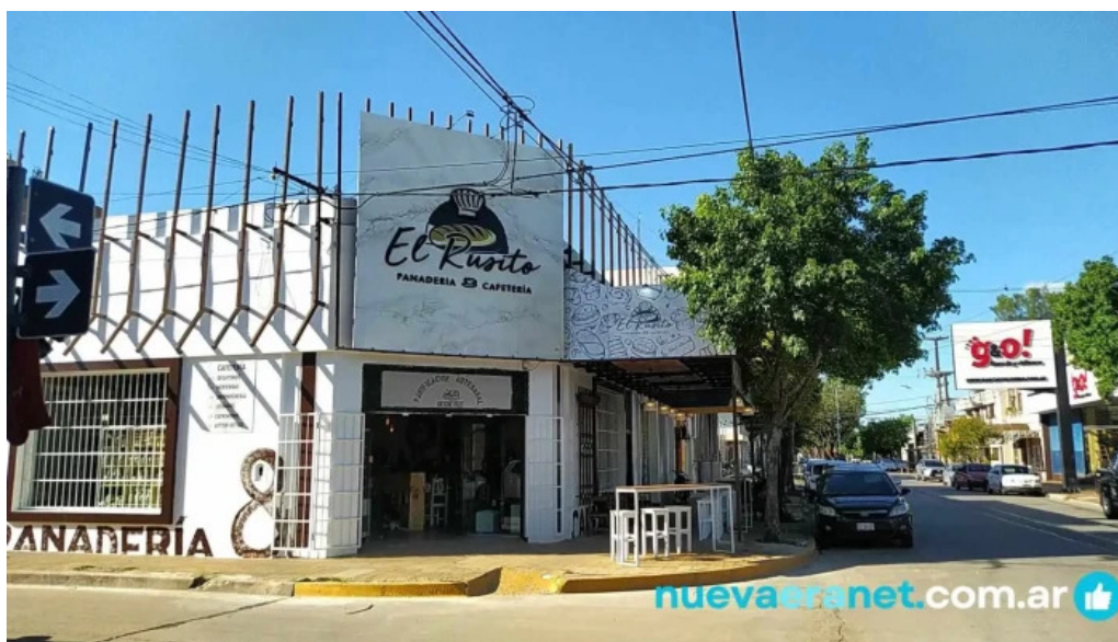
Panaderia y cafeteria el rusito zona
