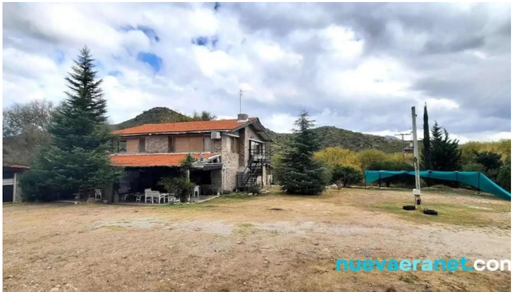
Sierras oasis apart exterior
