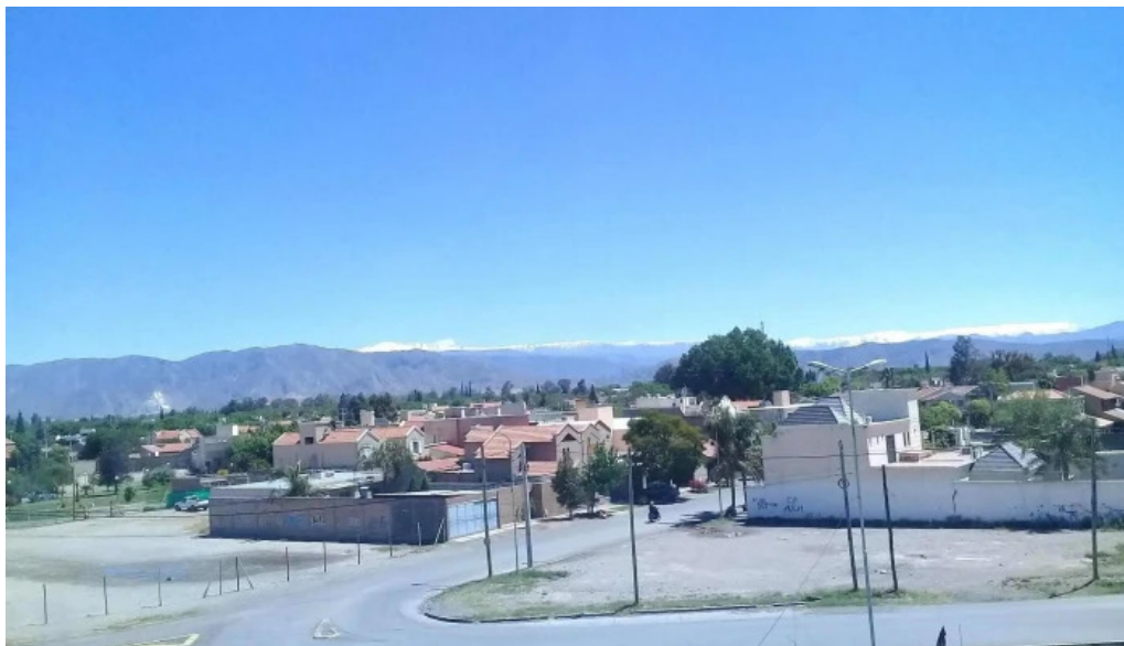
Casa san juan exterior
